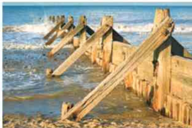
نصب حفاظ عمودی
