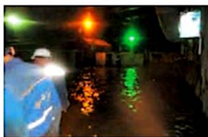
شکل ۱۰-۶. هجوم آب و گل و لای در زمان حفاری تونل‌ها
