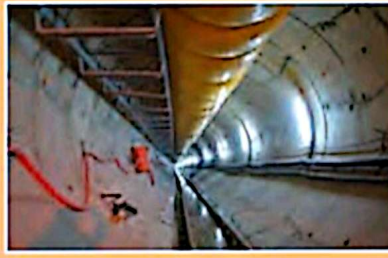
تونل انتقال آب (تونل کانی سیب - پیرانشهر)
