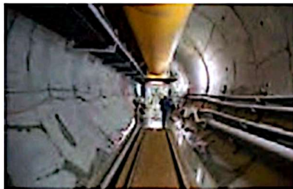
ب) پوشش‌های بتنی در مترو
