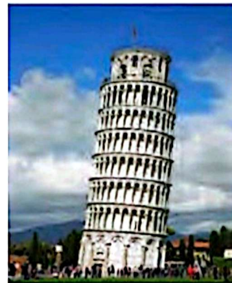
شکل ۱-۶ نشست نامتقارن پی در برج پیزا
