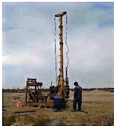
شکل ۳-۶- حفاری گمانه اکتشافی توسط دستگاه حفاری
