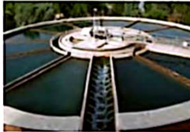
آب در تصفیه خانه
