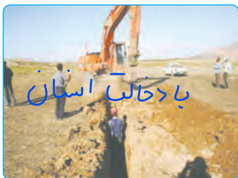
کندن زمین با بیل مکانیکی
