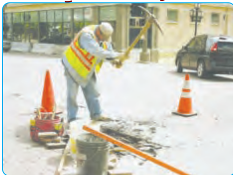
استفاده از کلنگ در کندن زمین
