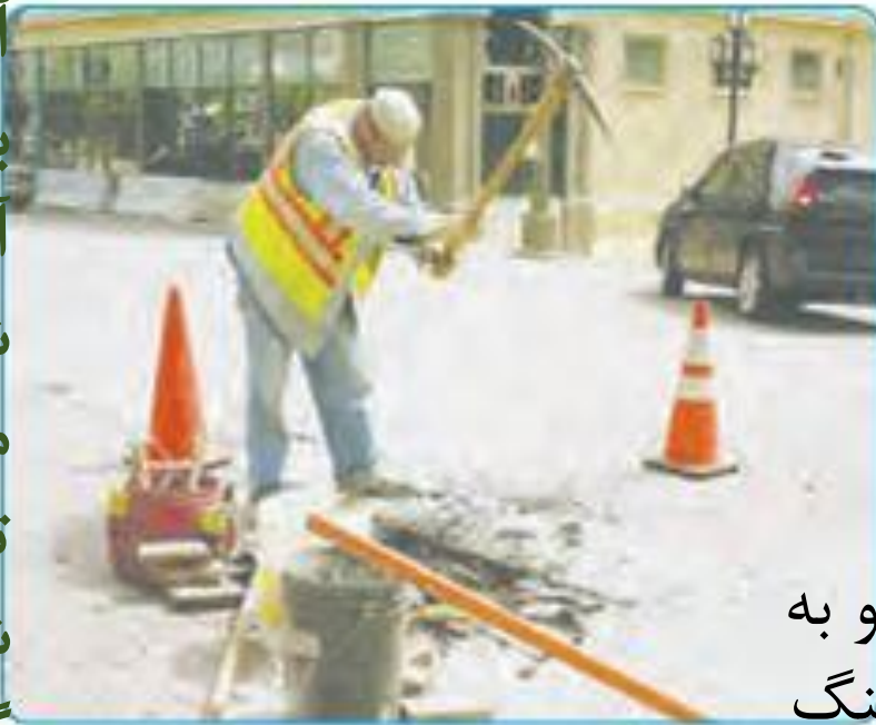
استفاده از کلنگ در کندن زمین
