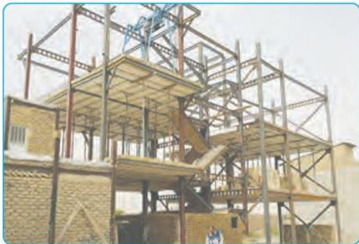
خانه‌ی در حال ساخت
