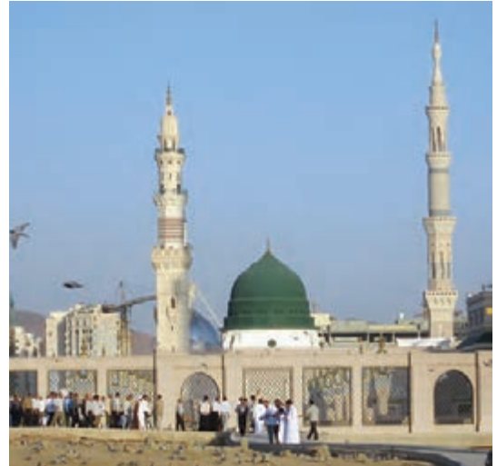
مسجد النبی، نمای بیرونی
