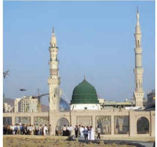
مسجد النبی، نمای بیرونی
